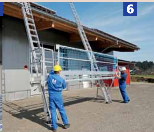
6. Geländer, Seitenschutz und Einstiegsmodul anbringen
