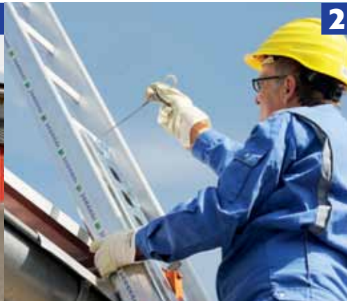
2. Aufzug-Vorrichtung an der Leiter einhängen
