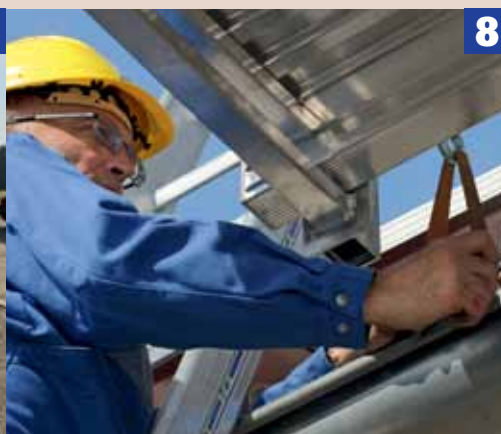
8. Sichern des Systems gegen Umfallen
