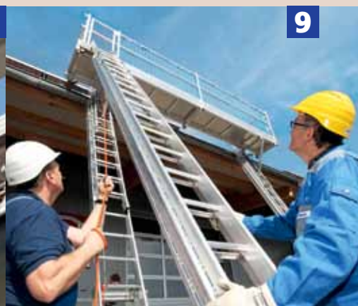
9. Zugangsleiter positionieren
