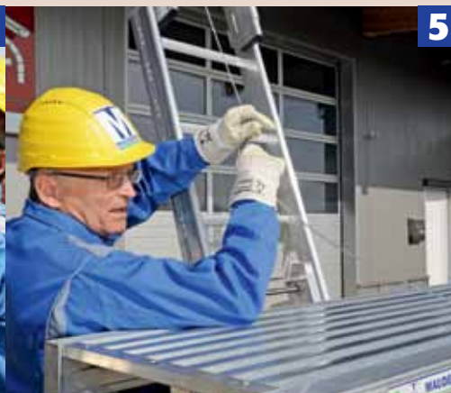
5. Arbeitsplattform am Schlitten fixieren
