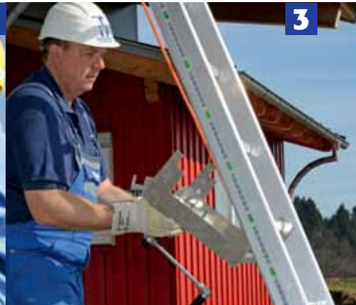
3. Seilwinden an den Leitern einhängen
